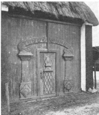
Den gamle Fabriksport.
